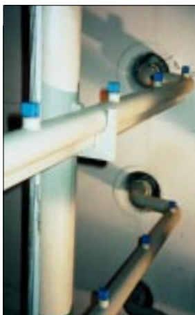
Détail du système de buses de pulvérisation
