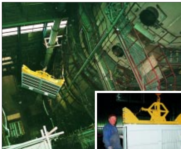
Installation d'un LTH 100 dans une usine de désulfuration de gaz de fumée
