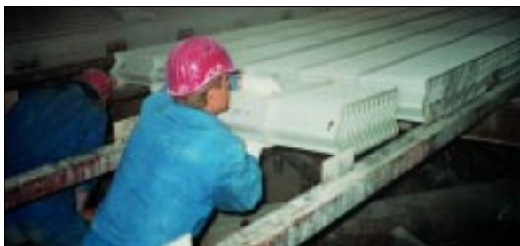
Assemblage du LTV 400, en plastique, dans une installation de désulfuration de gaz de fumée
