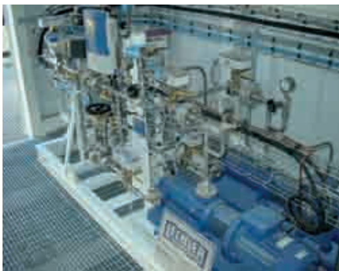
Skid de pompage et régulation compact pour installation dans un container
